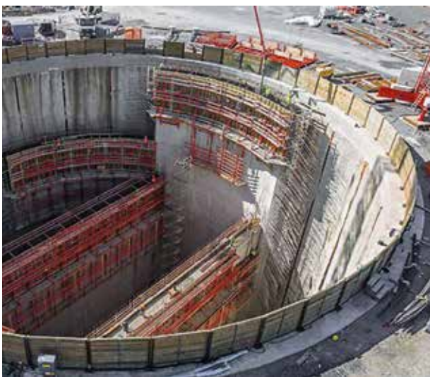
Die tiefste Baustelle im Ruhrgebiet
