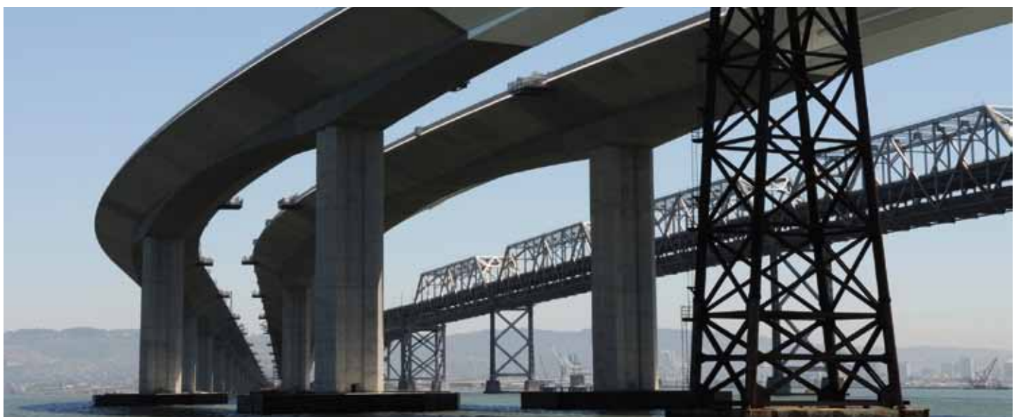
Brückenbau: Zement ist ein entscheidender Faktor.
